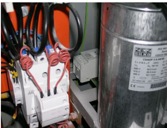
Rys.3.1 Wymiana kondensatorów i styczników montaż indukcyjnych modułów szybkiego rozładowania kondensatorów.
