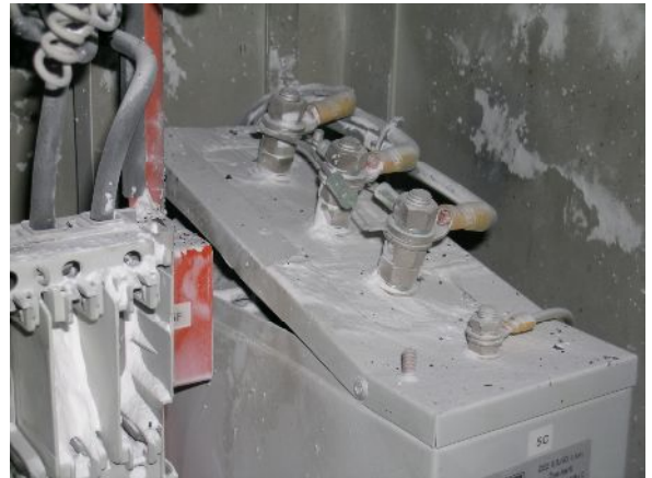
Rys.3.2 Stopień 5 baterii wybuchł i zapalił się
