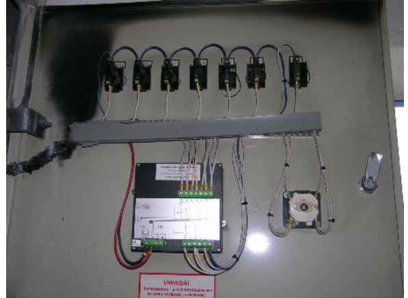
Rys.1.2 Regulator załączył nierozładowane kondensatory
