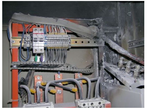
Rys.2.2 Stopień 4 baterii wybuchł i zapalił się
